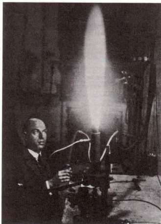
3 Max Valier (1895–1930) bei einem Brennkammerversuch. Zur Messung der Schubkraft diente ihm eine Küchenwaage 4 Eine Rakete vom Typ Aggregat 4, der ersten Großrakete mit Flüssigkeitstrie-
