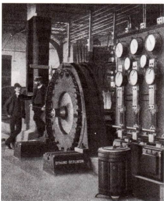
1 Das Versuchskraftwerk in Lauffen für die erste Fernleitung elektrischer Energie, in Betrieb genommen 1891
