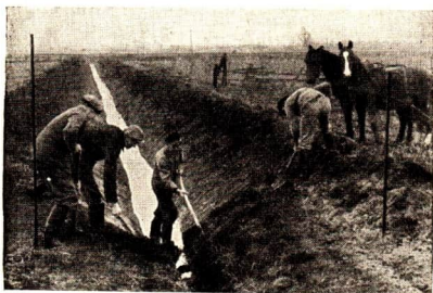
Abb. 67 Räumung eines Entwässerungsgrabens
