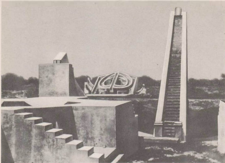
Astronomisch-mathematische Bauwerke aus dem 17. Jh. zur Bestimmung von Zeit, Deklination und Stundenwinkel (bei Delhi)
