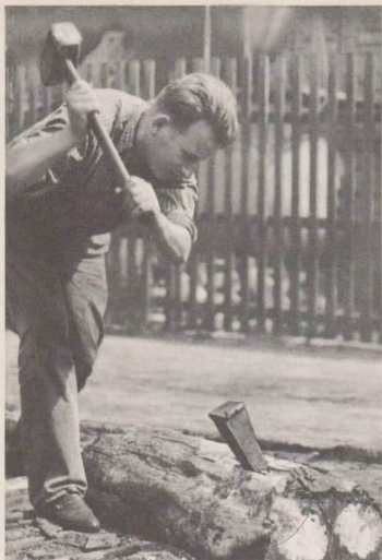
Keil als Spaltwerkzeug
