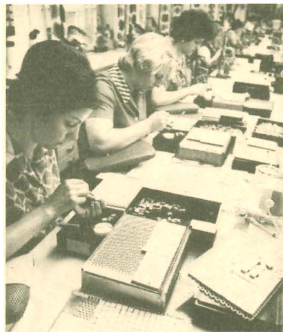
Produktion regelbarer Widerstände für Fernseh-, Rundfunk- und Tonbandgeräte im VEB Bauelemente Dorfheim
