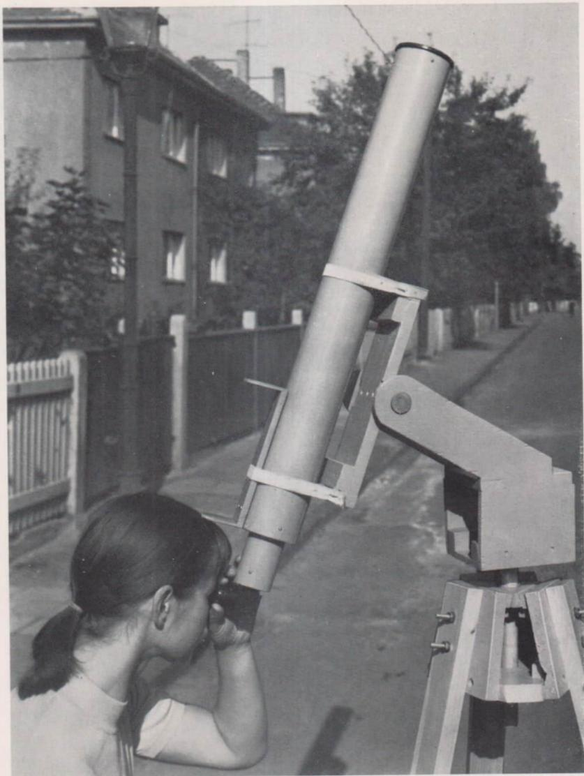
Das Selbstbaufernrohr mit angesetzttem Zenitprisma
