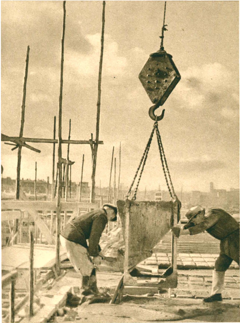
Die Decke eines Wohnblocks wird betoniert. Das Foto ist eine technisch und inhaltlich gut gelungene Wiedergabe des unaufhaltsamen Aufbaus unserer demokratischen Heimat.
