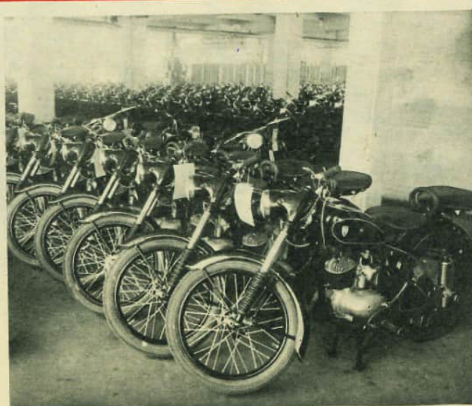
RT 125/2; Einzylinder-Zweitaktmotor; Leistung: 4,5 PS (3,3 kW). Die Kette ist mit Gummikapsel versehen, der Federweg etwas erhöht, und im Scheinwerfergehäuse zeigt ein Lämpchen den Leerlauf an. Baujahr: 1956.
