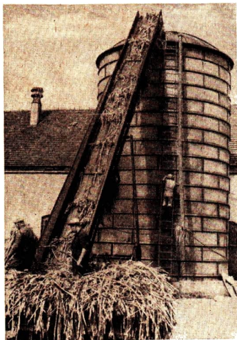
Abb. 30 Ein eiserner Hochsilo wird mit Sonnenblumen gefüllt. In solchen Hochsilos werden auch Rübenblätter eingelagert.
