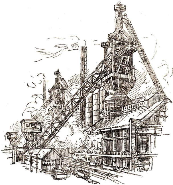
Abb. 165. Moderne Hochofenanlage. – Die Hochofen sind in die Werkhallen eingebaut. Von links führt der Schrägaufzug zur Gichtbühne, während in den Rohrleitungen von der Gicht nach rechts die Gichtgase abgeleitet werden. Zwischen Schrägaufzug und Hochofen sind die Winderhitzer als Stahlzylinder sichtbar.
