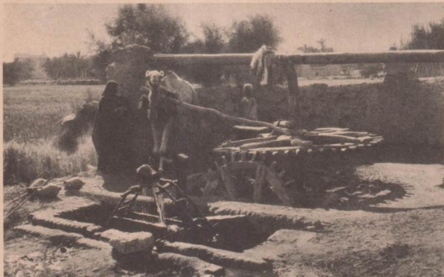
Ägyptische Sakije mit Göpelwerk. Die Sakije besteht aus einem vertikalen Rad, über das Palmenstricke laufen, an denen die Schöpfgefäße befestigt sind. Der Antrieb des Rades erfolgt durch ein Göpelwerk, das durch Kamele oder Ochsen in Bewegung gesetzt wird. Diese Methode des Wasserhebens ist noch heute im Vorderen Orient verbreitet.
