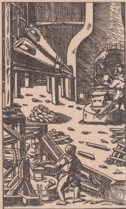
Stahlhütte. Im Hintergrund Schachtofen mit Blasebalg, im Vordergrund Schwanzhammer mit Nockenwelle (aus »De re metallica«)
