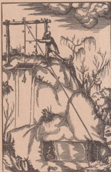
Markscheider bei der Vermessung eines Schachtgebäudes. Durch einfache Verhältnisrechnung bestimmt er, wie tief der Schacht bis zur Stollensohle abgeteuft bzw. wie weit der Stollen bis zum Schacht vorgetrieben werden muß (aus G. Agricola »De re metallica«, Basel 1556).
