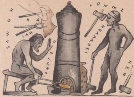
Metallguß in der Eisenzeit. An die Stelle der über offenem Herdfeuer verwendeten Schmelzkübel ist der Schmelzofen gerückt. Neu ist auch die zweiteilige, durch eine Schraube verbundene Zange (nach einem attischen Vasenbild, 5. Jh. v. u. Z.).
