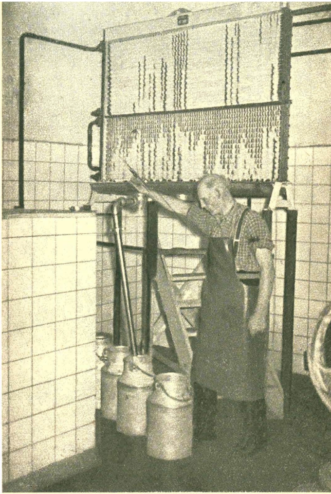
Die Genossenschaft verfügt über eine eigene Kühlanlage
