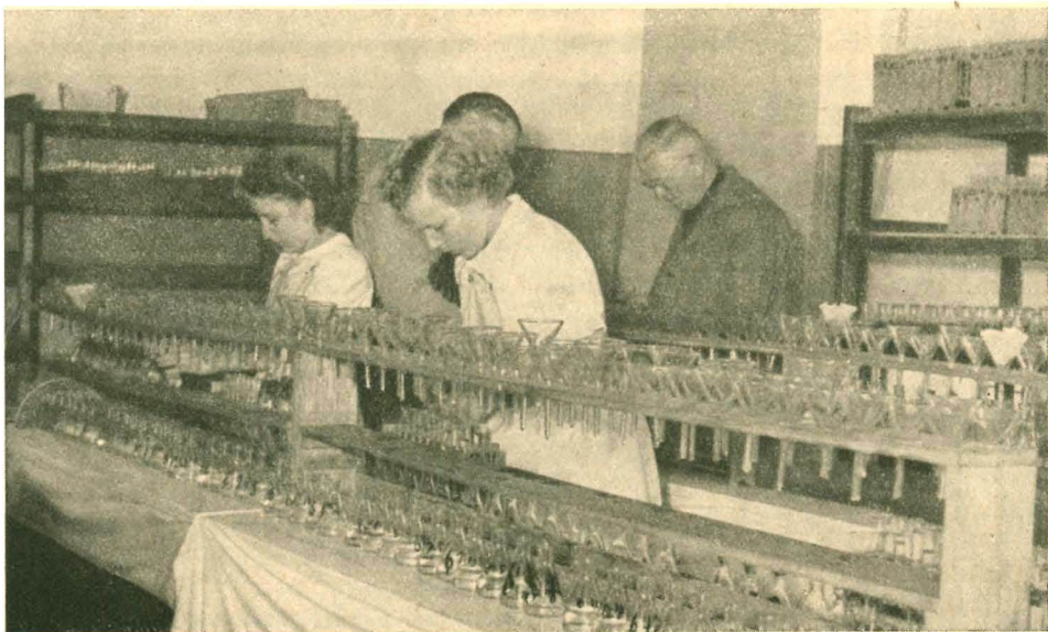
Labor eines Instituts für landwirtschaftliches Versuchs- und Untersuchungs-wesen. Hier werden die Bodenproben auf ihren Nährstoffgehalt untersucht
