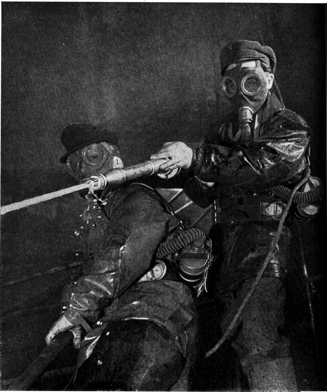
Eine Atemschutzmaske und Ölkleidung müssen die Männer oft bei besonderen Arbeiten tragen. Mit einem scharfen Wasserstrahl und einer Stange wird der Schmutzwasserabfluß einer Fabrik gereinigt
