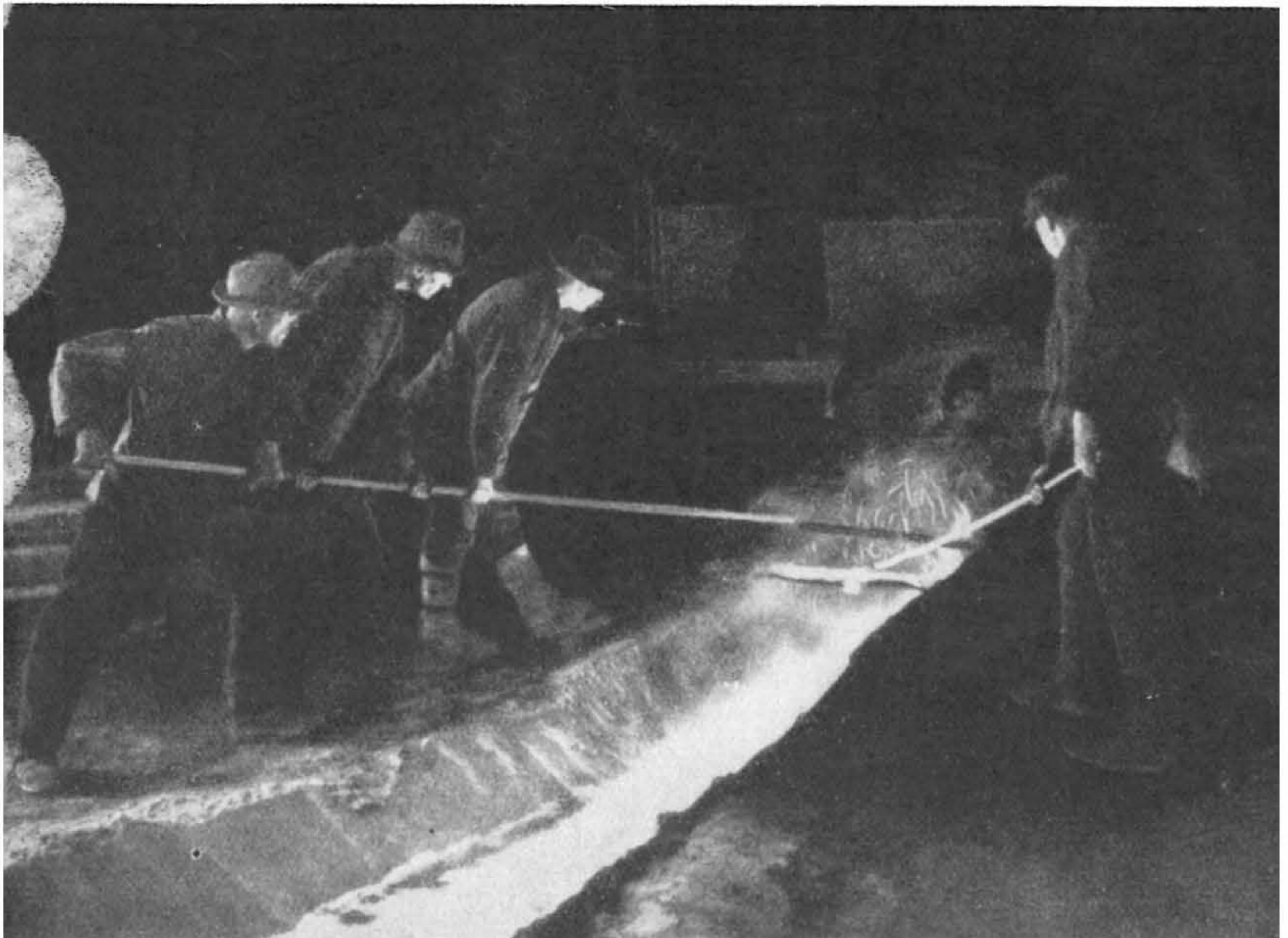
Bild 19 Ausfluß des Roheisens in die Abstichrinne.
