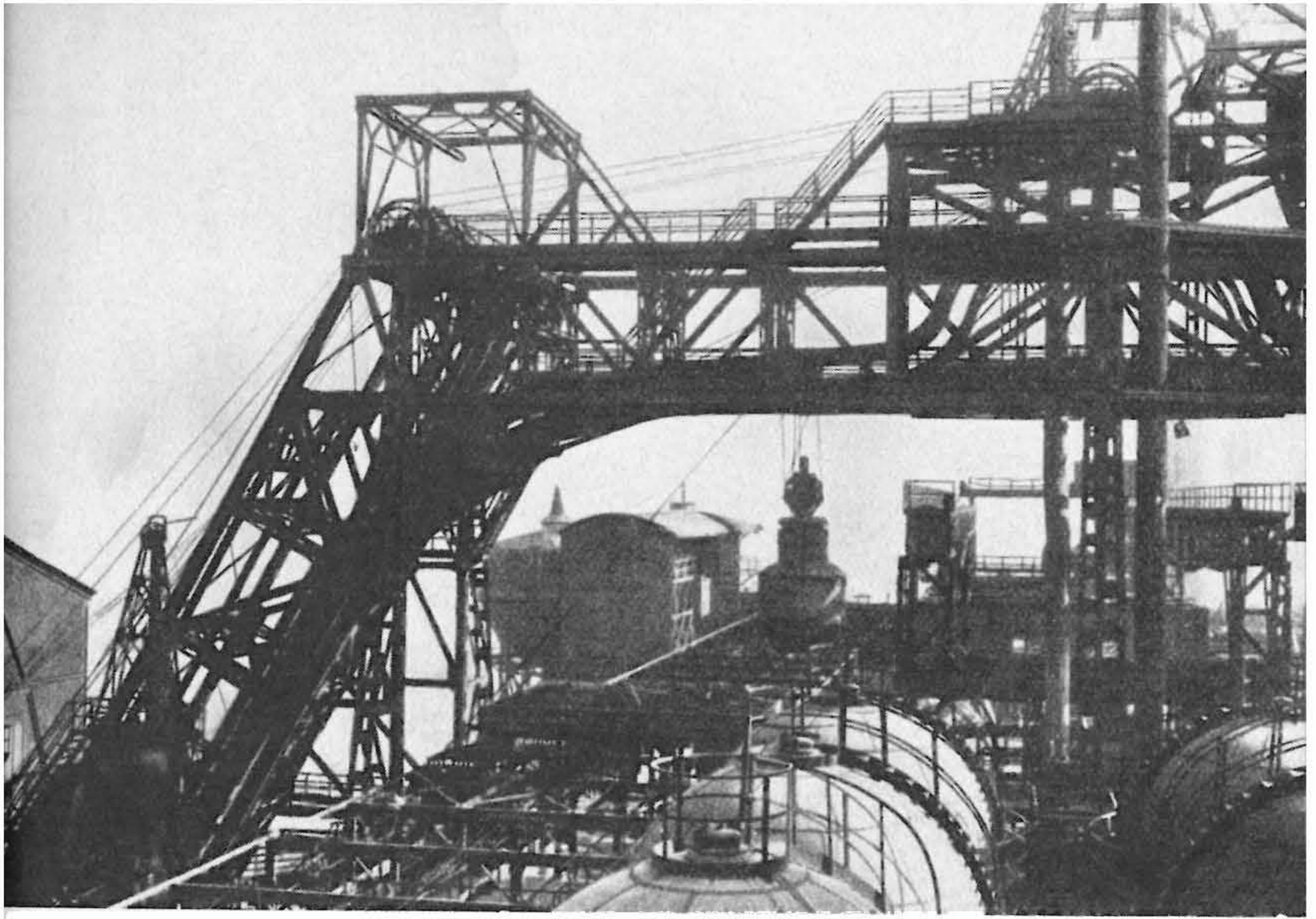
Bild 14 Blick auf die Hochofenbegichtung über den Winderhitzern.
