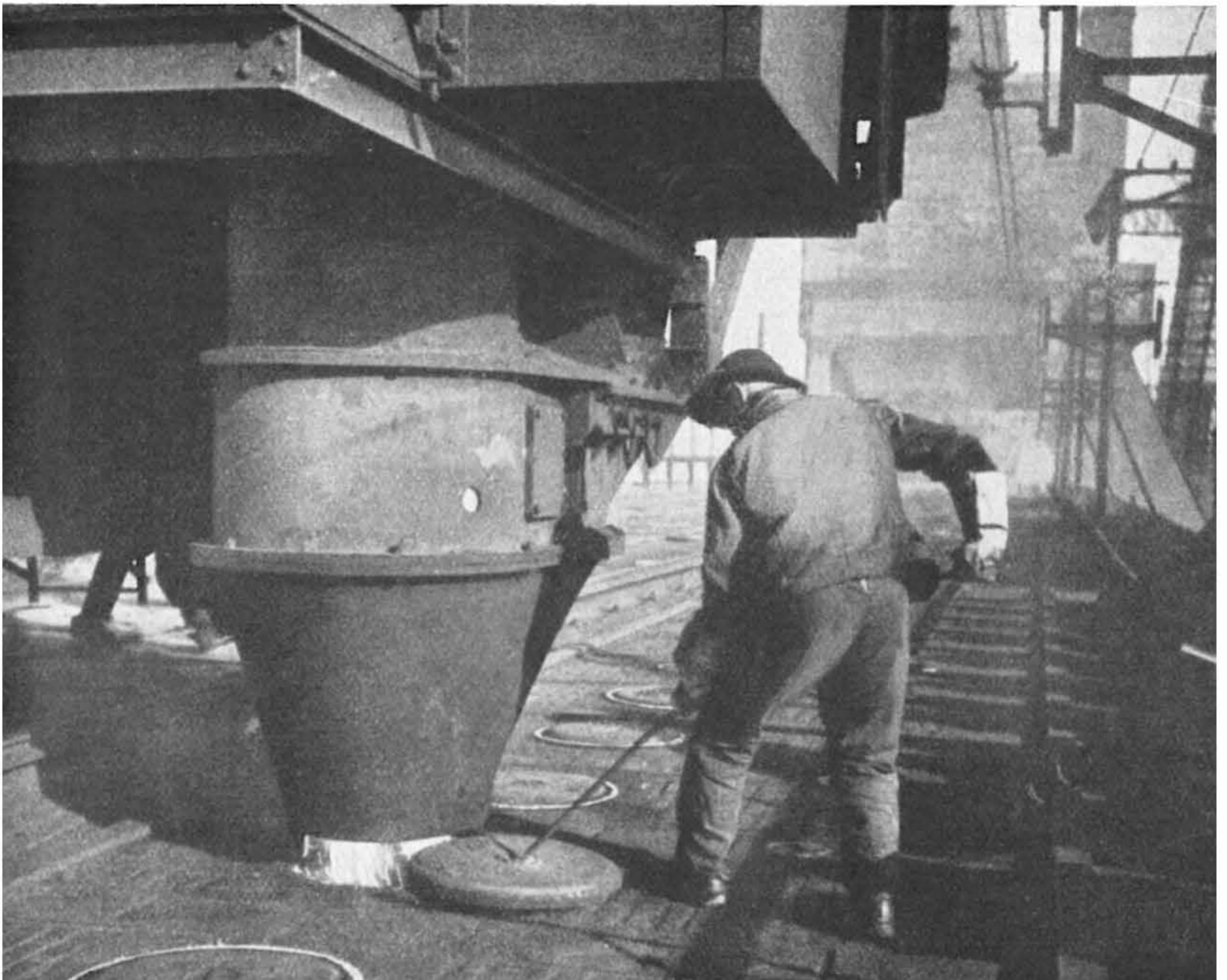
Bild 11 Einfüllen von Kohle aus dem Füllwagen in einen Koksofen. Im Hintergrunde der Kohlenturm.
