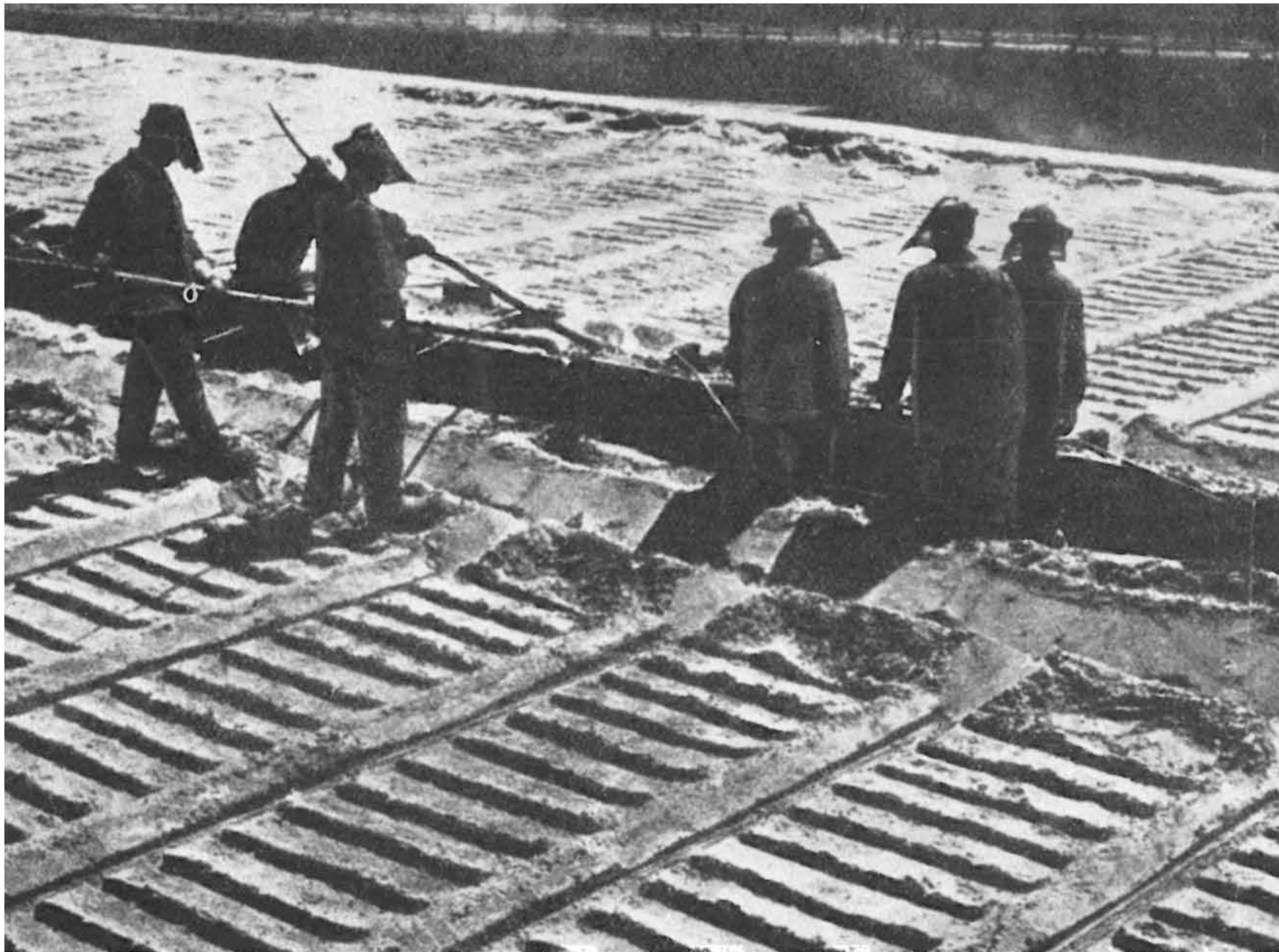
Bild 20 Masselguß. Arbeiter mit Schutzmasken überwachen den Eisenfluß.
