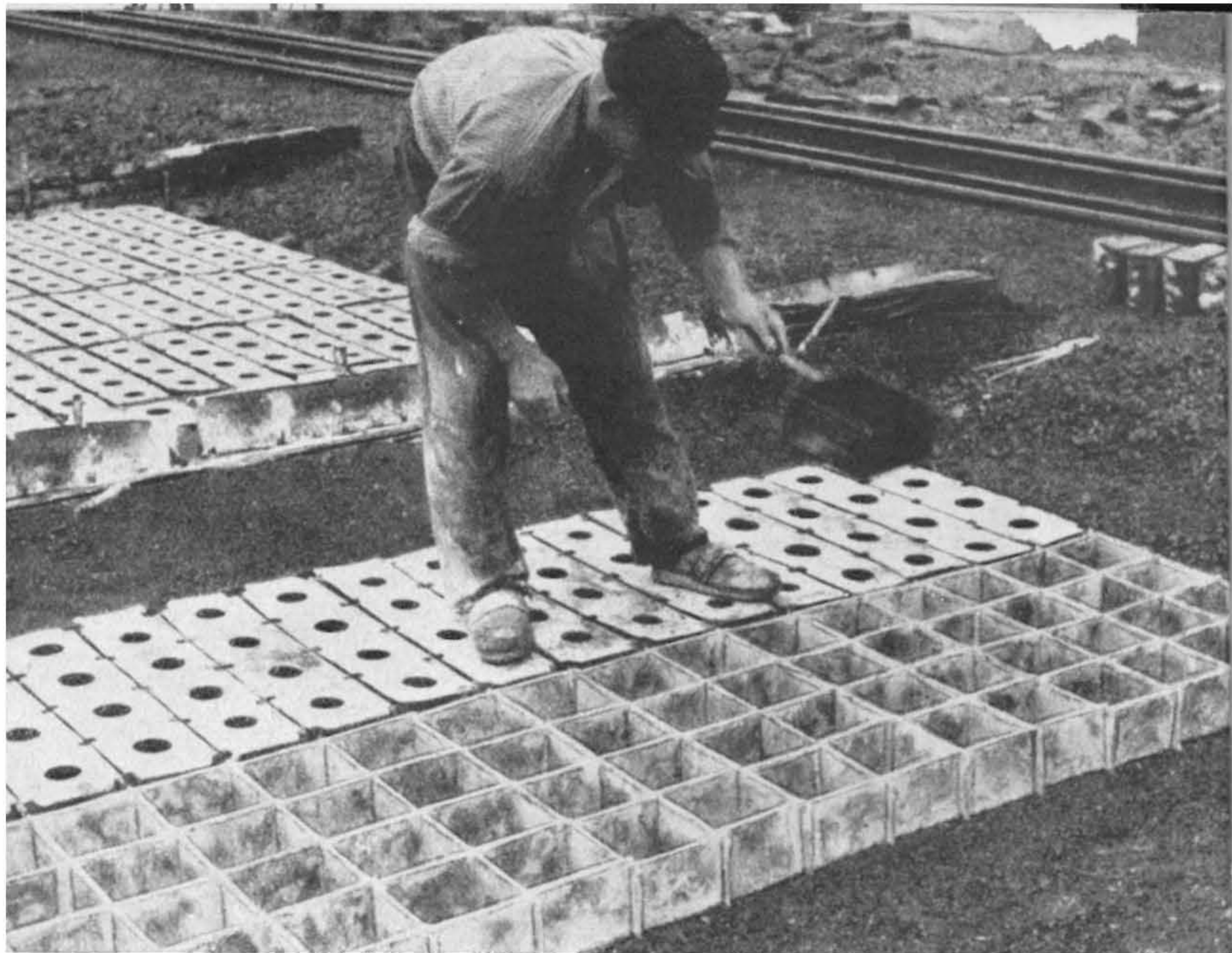
Bild 16 Die Gießgrube wird mit Formblechen ausgelegt.
