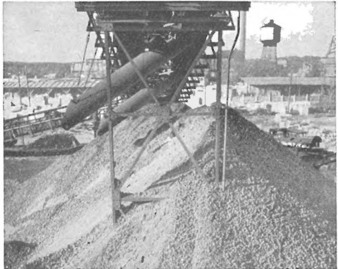
Abb. 17. Gelagerter Koks und gelagerte Braunkohle müssen im Sommer oft mit Wasser besprengt werden, damit sie sich nicht selbst entzünden.
