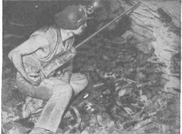
Abb. 91. Kumpel aus dem Mansfelder Kupferbergbau brechen Kupferschiefer mit dem Preßlufthammer. In der Deutschen Demokratischen Republik wird Kupfer aus Mansfelder Kupferschiefer gewonnen.
