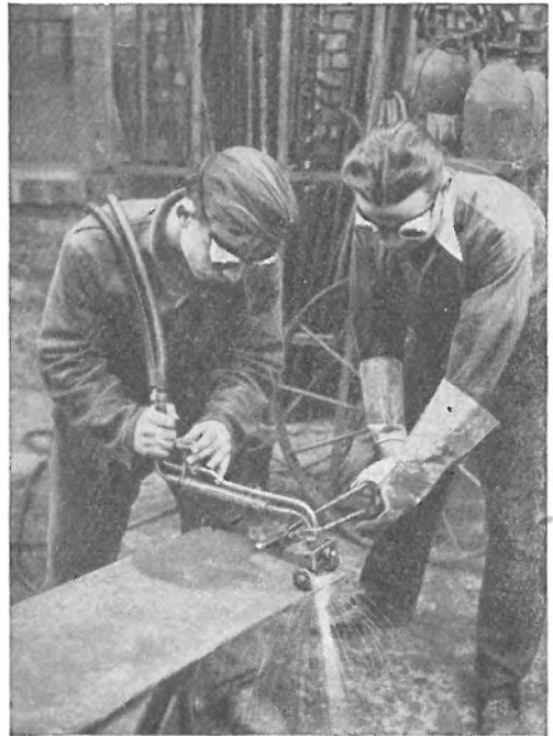
Abb. 9. Lehrlinge beim Arbeiten mit dem Schneidbrenner
