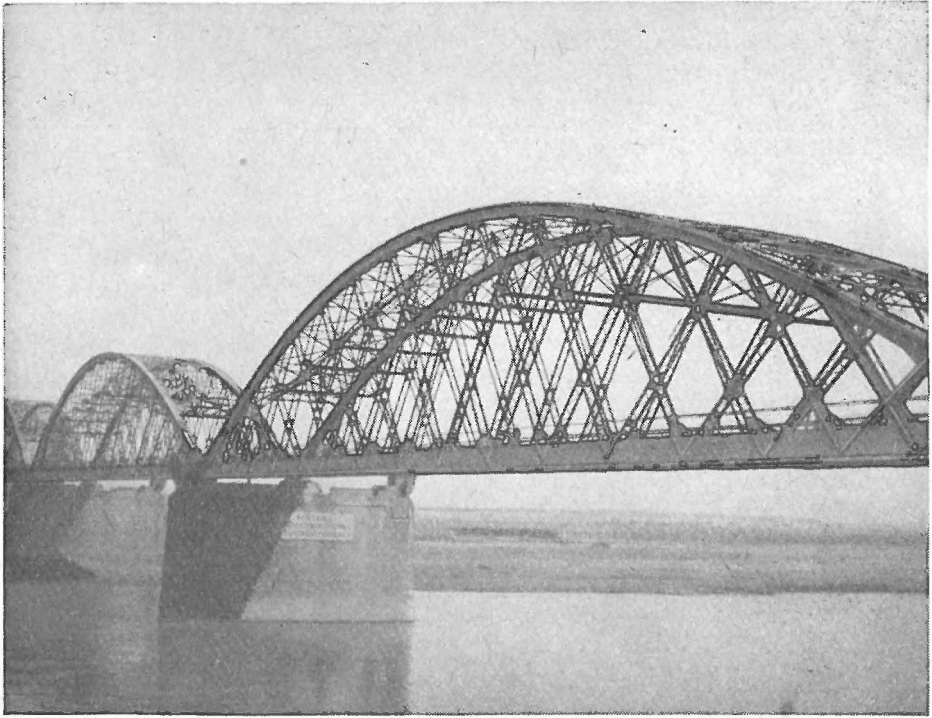
Abb. 56. Stahlbrücke bei Riesa
