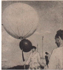
Bild 269. Start eines Registrierballons. In 15000 m Höhe platzt der Hauptballon. Das Gerät sinkt mit Fallschirm und dem roten Signalballon zu Boden
