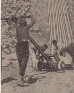
Bild 40. Transport schwerer Steinblöcke
