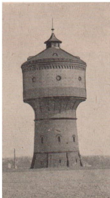
Bild 237. Sammelbehälter einer Wasserleitung
