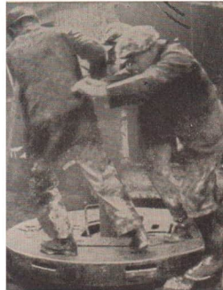
Bild 44. Drehmoment beim Verschrauben eines Bohrgestänges
