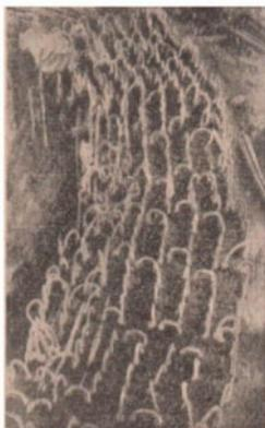
Bild 142. Befestigung eines Erdrutsches durch Einfrieren. Die oben herausragenden Röhre stehen mit einer Kälteanlage in Verbindung
