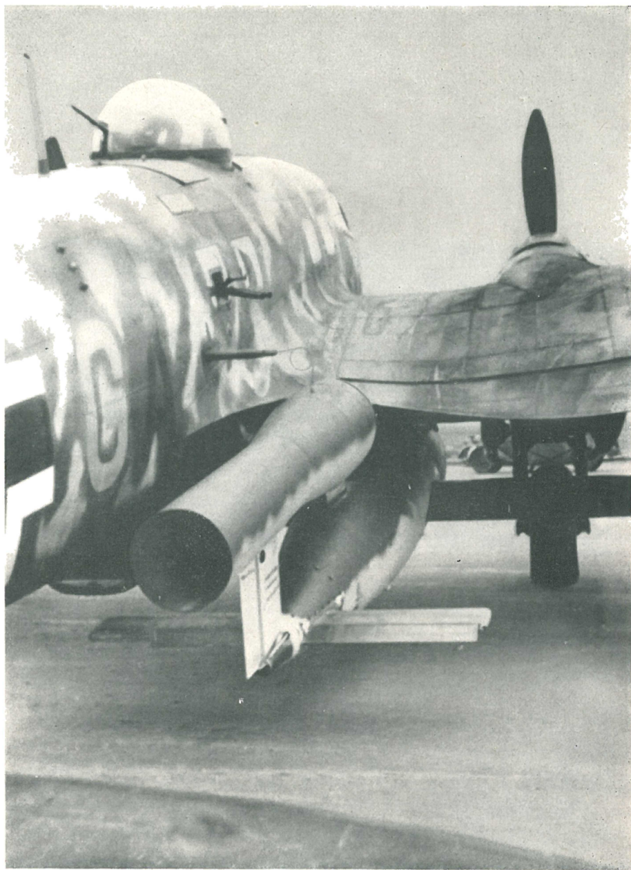
Nachdem die Abschussbasen zerstört waren, wurde die V 1 von Flugzeugen aus abgeschossen. Das Bild zeigt eine V 1 unter einer He 111
