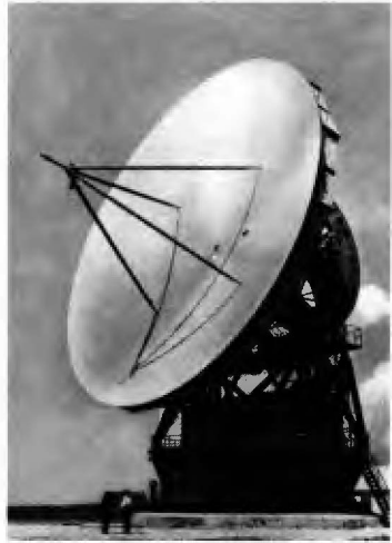
Radioteleskop der Radiophysikalischen Station des Lebedew-Instituts (UdSSR), ein parabolischer Reflektor mit einem Durchmesser von 22 m
