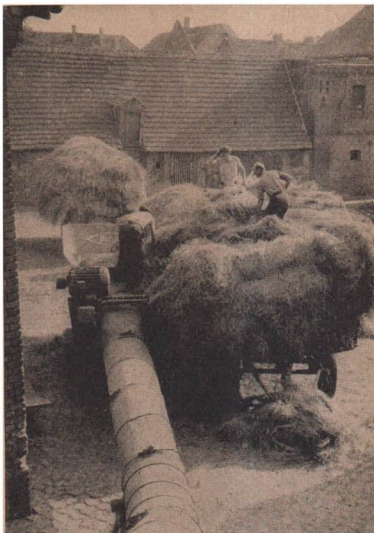
Abb. 161 Maschinen erleichtern die Arbeit bei der Heuernte. Mit dem Gebläse wird ein Heuwagen in sieben bis acht Minuten entladen.
