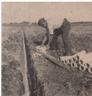
Abb. 163 Durch in die Erde gelegte Tonröhren wird die Wasserversorgung des Grünlandes geregelt
