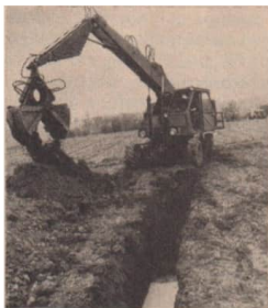
30/1 und 30/2 Anlagen von Entwässerungsgräben und Beregnungsanlage
