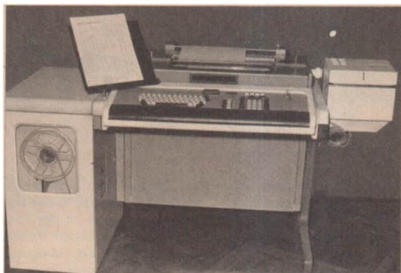
118/1 Schreibeinheit, bestehend aus Schreibmaschine (Mitte), Lochbandstanzer (rechts) und Lochbandleser (links)
