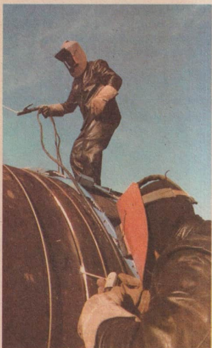
54/1 Verbinden von Rohren der Drushba-Trasse durch Schmelzschweißen
