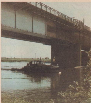
66/2 Brücke moderner Bauart mit leicht durchführbarem Korrosionsschutz
