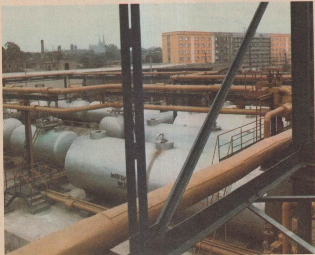
59/1 Korrosionsschutzte Anlagen in einem Chemiebetrieb
