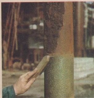
61/1 Feinentrost mit der Drahtbürste
