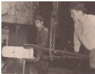
Bild 6 Schmieden von Stahl mit einem Maschinenhammer
