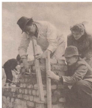
Bild 1 Prüfen mit der Wasserwaage
