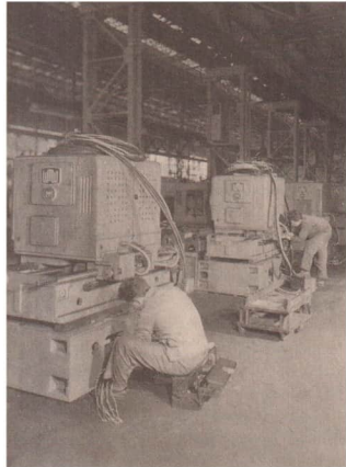
Bild 2 Serienfertigung von Bearbeitungsmaschinen für Taktstrassen
