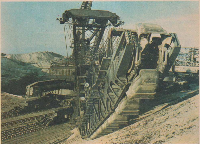
8/1 Förderbrücke im Braunkohlentagebau Jänschwalde
