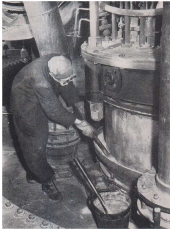
Abdichten der Stopfbuchse für eine der Söderberg-Elektroden auf dem Deckel des Phosphorofens im VEB Stickstoffwerk Piesteritz
