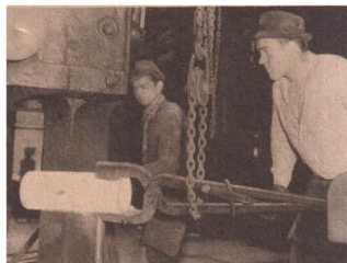
Bild 105/1 Schmieden von Stahl mit einem Maschinenhammer
