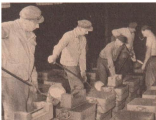
Bild 105/3 Gießen von Grauguß in Sandformen
