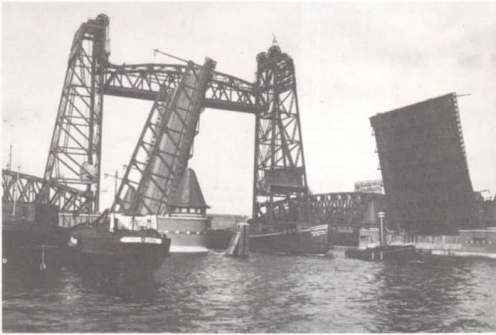
Stählerne Klappbrücke in Rotterdam
