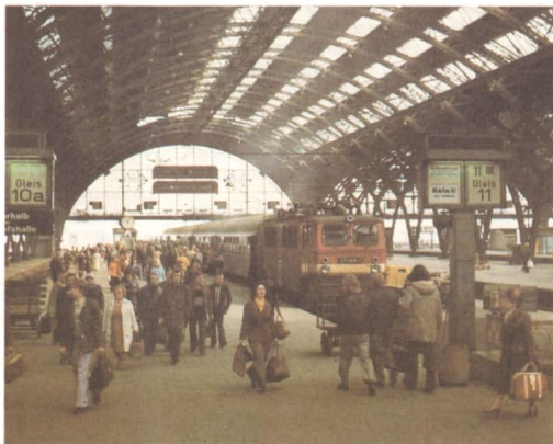
Leipziger Hauptbahnhof: In jeder seiner sechs Bahnsteighallen herrscht Tag und Nacht Verkehr
