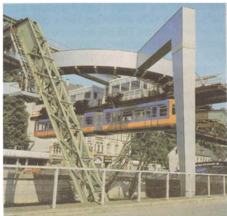
Seit 1903 ist die Wuppertaler Schwebebahn in Betrieb, sie wurde vor einigen Jahren modernisiert
