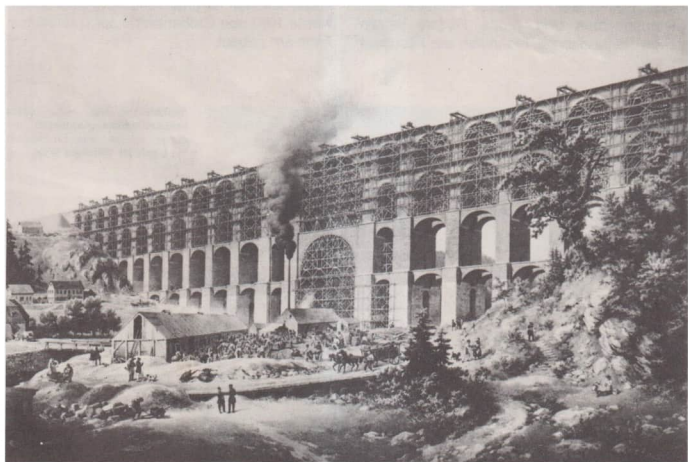
Die Göltzschtalbrücke für die Eisenbahn Leipzig—Hof während des Baues um 1850. Sie ist eine der größten Steinbrücken
