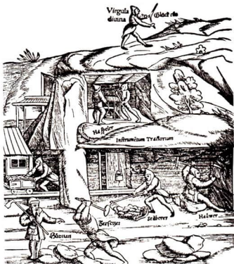
In der „Cosmographia Universalis“ des Sebastian Münster von 1550 ist ein auf Schienen laufender Wagen in einem Bergwerk dargestellt
