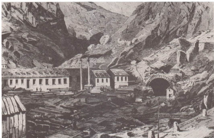
Bau der nördlichen Einfahrt in den St.-Gotthard-Tunnel 1874
