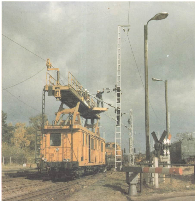
Bei der Elektrifizierung des Streckennetzes der Deutschen Reichsbahn erleichtern Fahrleitungs-Montagewagen die Arbeit der Techniker
