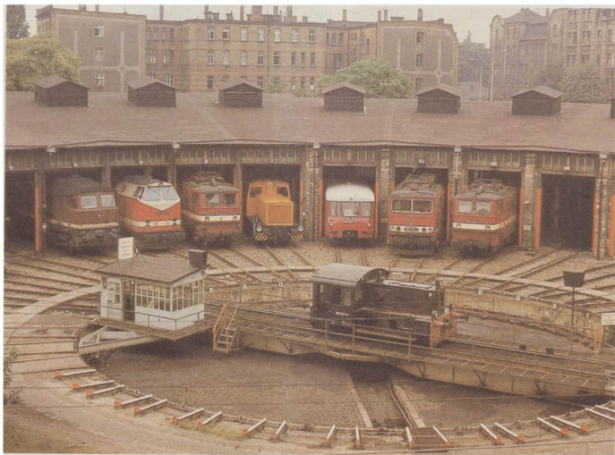
Diesel- und Elektrolokomotiven in einem Rundschuppen
