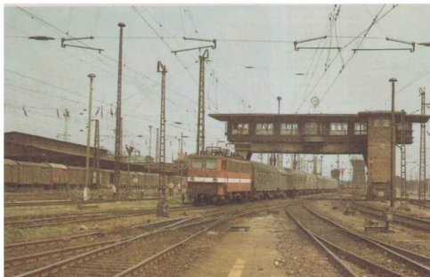
Kommandozone jedes Bahnhofs ist das Stellwerk
