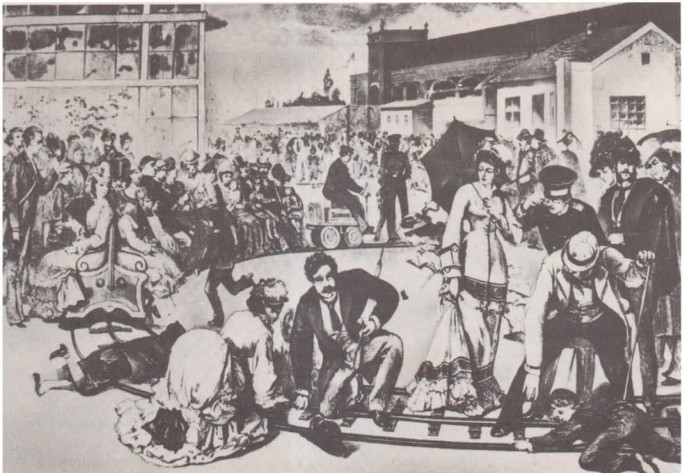
Nicht nur für Kinder war das „Kontaktsuchen“ bei der ersten elektrifizierten Schienenstrecke ein Erlebnis
