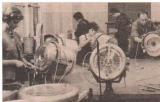
59/1 Schülerproduktionsabteilung – Montage von Wäscheschleudern
