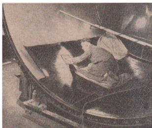
116/1 Auskleiden eines Behälters
