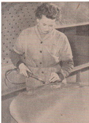
112/2 Schweißen eines Plastbehälters mit dem Heißluft-Schweißbrenner
