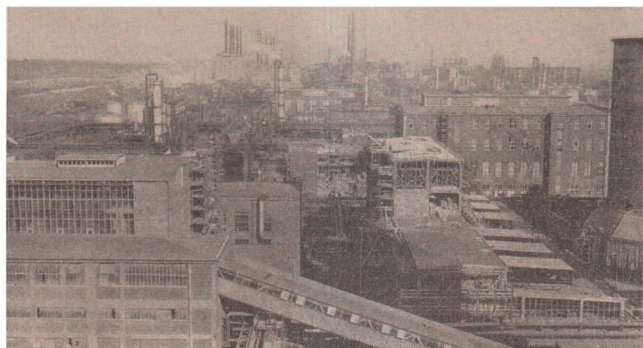
145/2 VEB Leunawerke „Walter Ulbricht“ nach dem Wiederaufbau
