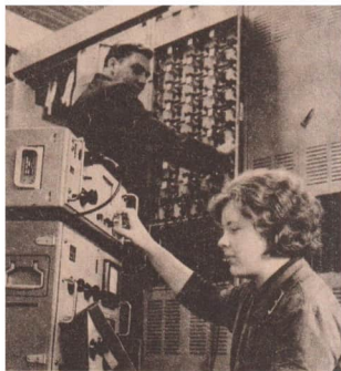
7/2 Prüf- und Meßarbeiten an einer Vermittlungsanlage
