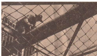
9/1 Schutznetze helfen die Unfallgefahr zu vermindern
