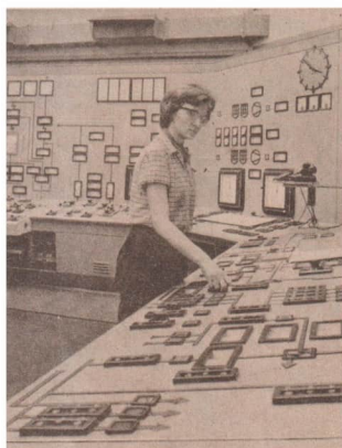
79/2 Zentrale Schaltwarte im Kraftwerk Schwarze Pumpe
