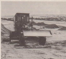
Durch Straßenbau wird die Kippe erschlossen, und die Bodenverbesserung kann beginnen. Zuerst werden große Mengen Braunkohlenfilterasche aufgebracht und tief in den rohen Boden eingearbeitet.
