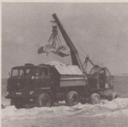
Der saure Kippenboden wird anschließend mit Kalk neutralisiert.
