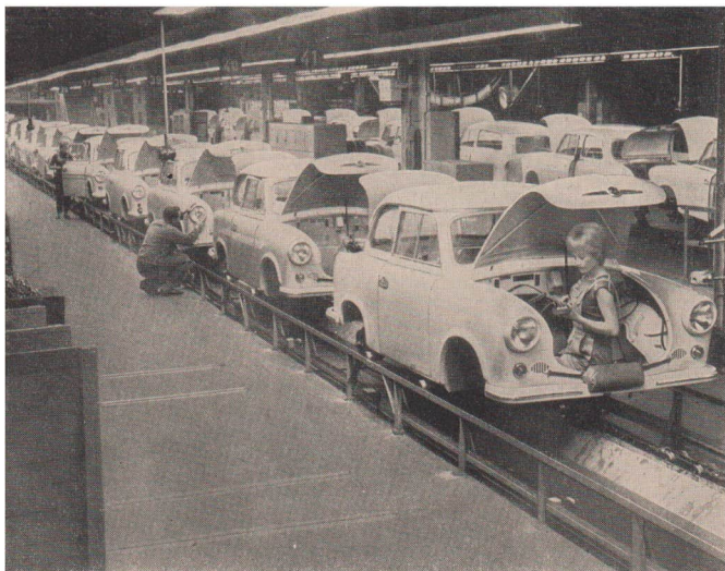
95/1 Taktstraße der Trabantfertigung. Die Karossen werden in bestimmten Zeitabständen weitergerückt. Vorherrschend Handarbeit
