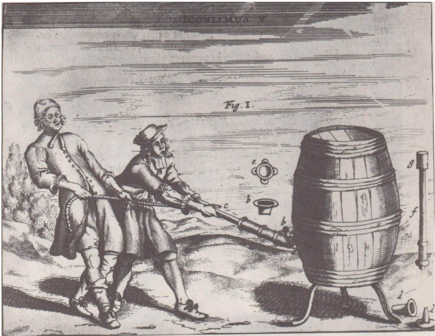
Versuch, mittels einer Luftpumpe in einem Faß ein Vakuum zu erzeugen
