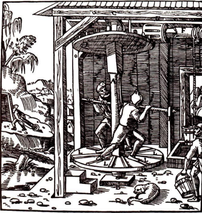
Legendes Tretrad, wie es einst im Bergbau eingesetzt wurde
