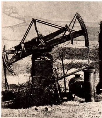
Abb. 2.7./3 Überreste einer wahrscheinlich von Newcomen gebauten Maschine, die noch 1830 in Betrieb war (Aufnahme von 1894)
