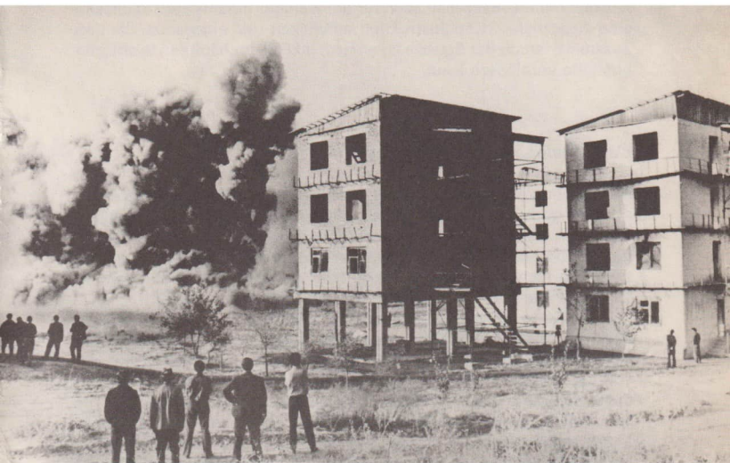
Mitarbeiter des Instituts für erdbebensicheres Bauen und Seismologie der Akademie der Wissenschaften der Tadshikischen SSR setzen Versuchsgebäude künstlichen Erdstößen aus.
