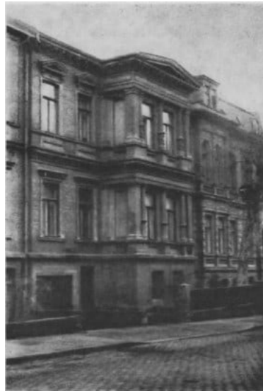
11 Cantors Wohnhaus in Halle, Händelstraße 13 (heutiger Erhaltungszustand)
