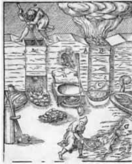
10 Schmelzofen zur Bleigewinnung um 1580
