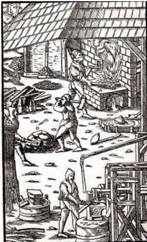
5 Rennfeuerbetrieb um 1550 (nach G. Agricola)
