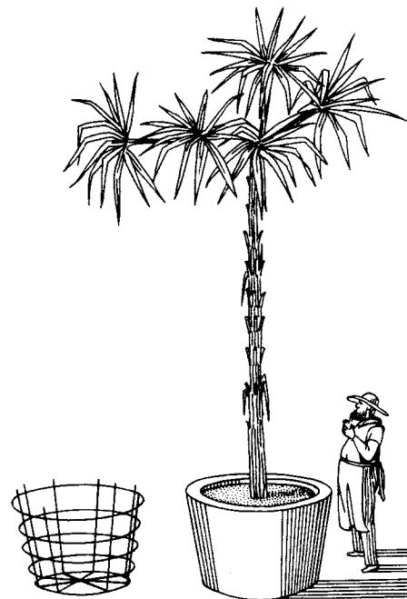
Zum ersten Mal wurden von Monier Bewehrungseisen in Betonbottichen für Palmen eingesetzt
