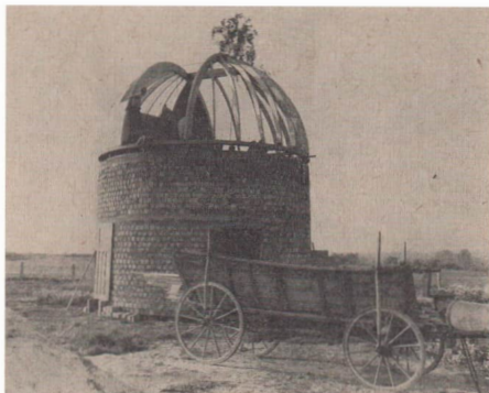
Abb. 3: Montage der 6-m-Drehkuppel im Oktober 1978.
