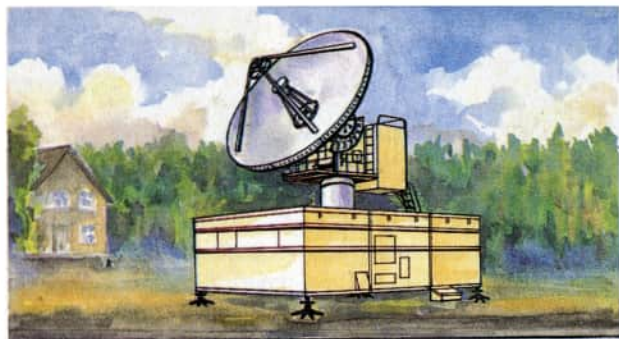
Die in drei Containern untergebrachte transportable Erdefunkstelle MARS (UdSSR)
