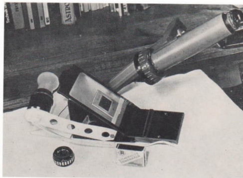
Zum Beitrag S. 55: Betrachtungsgerät mit Wechselobjektiv 4,5/50 in Arbeitsstel- lung.
