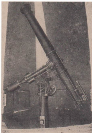
Abb. 2: Der 12 Zoll-Refraktor der Urania-Sternwarte ( d \approx 31 cm).
