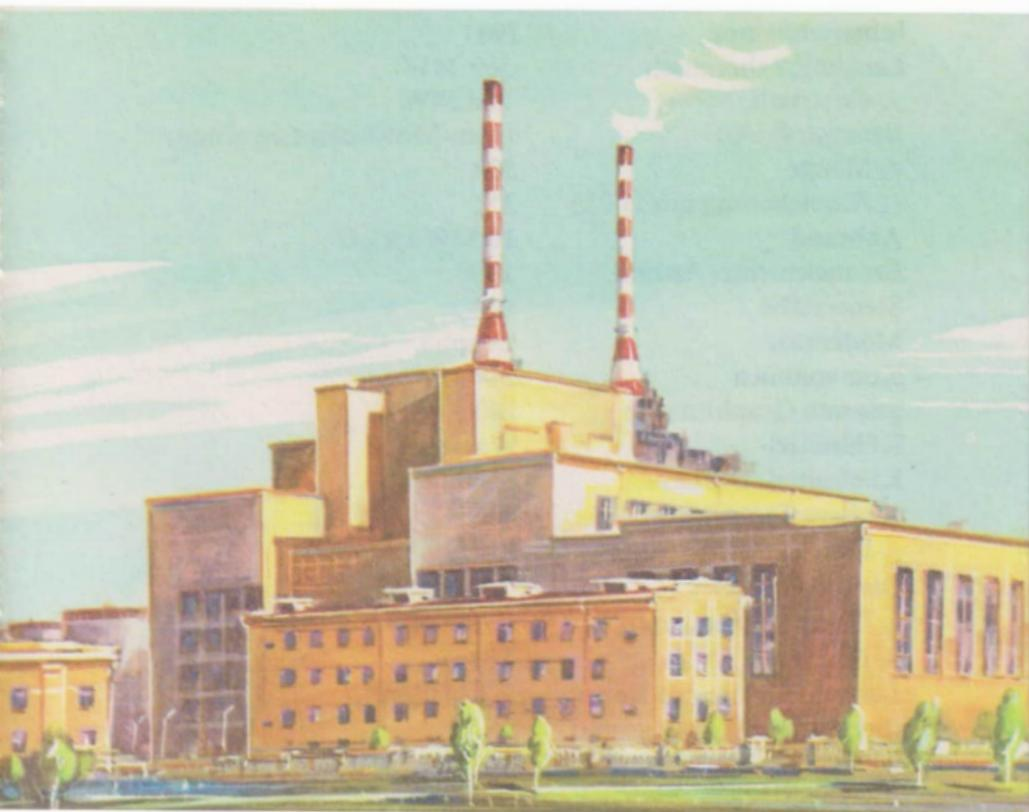
und sich allmählich in Dampf verwandeln. Da der Druck im Rohrsystem aber 100 at beträgt, unterbleibt die Dampfbildung. Es handelt sich um einen *Druckröhrenreaktor*. Seine Leistung mit  $30 \text{ MW}_{\text{th}}$  bzw.  $5 \text{ MW}_{\text{el}}$  nimmt sich im Vergleich zu den heute üblichen Dimensionen noch recht bescheiden aus. Aber es war das erste Studienobjekt, der erste Durchbruch auf dem Weg zur friedlichen Gewinnung von Kernenergie.
