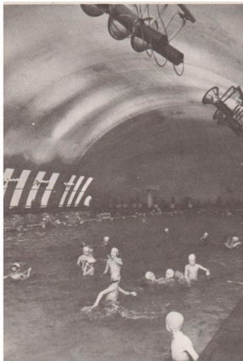
Dieses Bad in Schkopau könnte nur im Sommer genutzt werden, wenn man es nicht im Winter mit einer heizbaren Traglufthalle aus Polyamidnähe-wirk überspannen würde.
