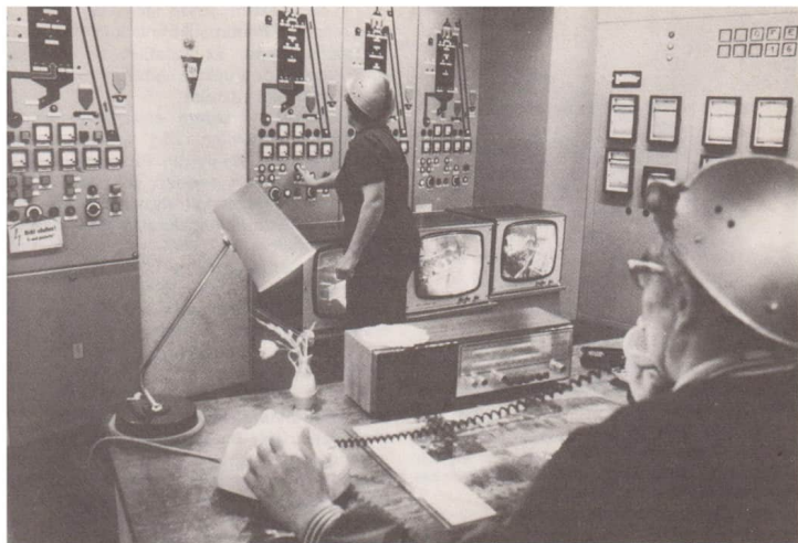
Steuerzentrale für eine moderne Zementanlage.
