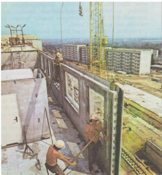
Anwendung industrieller Bauweisen: Versetzarbeiten im Karl-Marx-Städter Neubaugebiet »Fritz Heckert«
