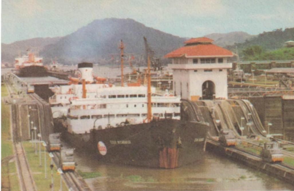
*Großer Tanker bei voller Abladung in den Mirafloresschleusen. Das Verholen der Schiffe bewerkstelligen Elektroloks.*
