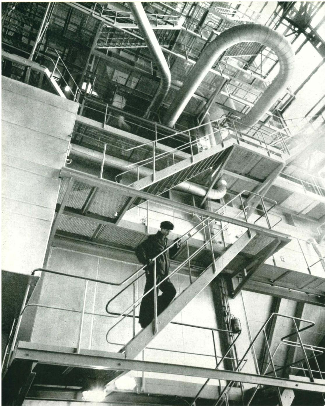
So sieht es im Kesselhaus des Wärmekraftwerkes Lübbenau aus. Riesige Kessel erzeugen den zum Antrieb der Turbinen notwendigen Dampf. Nach seiner Fertigstellung während des Siebenjahrplanes wird das Kraftwerk Lübbenau eins der größten Wärmekraftwerke Europas sein
