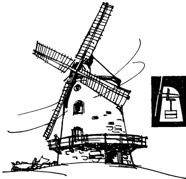
50 PS. Allerdings nutzen die Flügel der Windmühlen die Energie des Windes nicht voll aus. Selbst bei den modernen Windmühlen überschreitet der Wirkungsgrad der Flügel nicht 20 Prozent.
