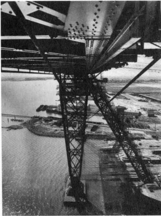
Gewaltige Stahl- konstruktionen (Kabelkrananlage der Warnowwerft)
