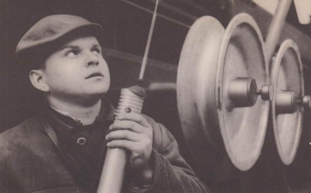
Kleinstfunkgerät im Einsatz. Mit seiner Hilfe werden Krane und Bagger dirigiert
