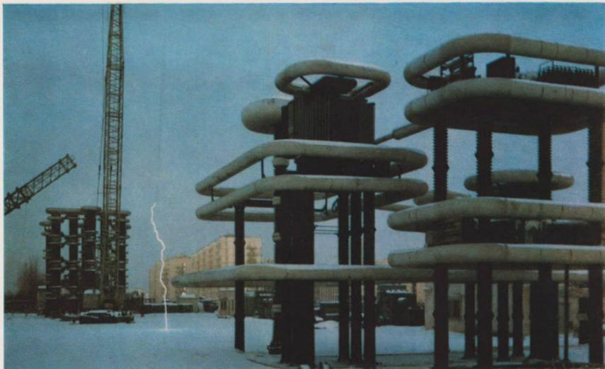
*TuR-Wechselspannungsprüfanlage 1800 kV, aufgestellt im Hochspannungsversuchsfeld des Instituts für Gleichstrom Leningrad*
