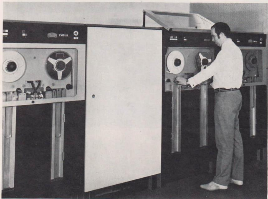
*Zur Peripherie von elektronischen Datenverarbeitungsanlagen gehören Magnetbandspeicher – sie sind Archiv, Lexikon, Ablage einer Datenverarbeitungsanlage*
